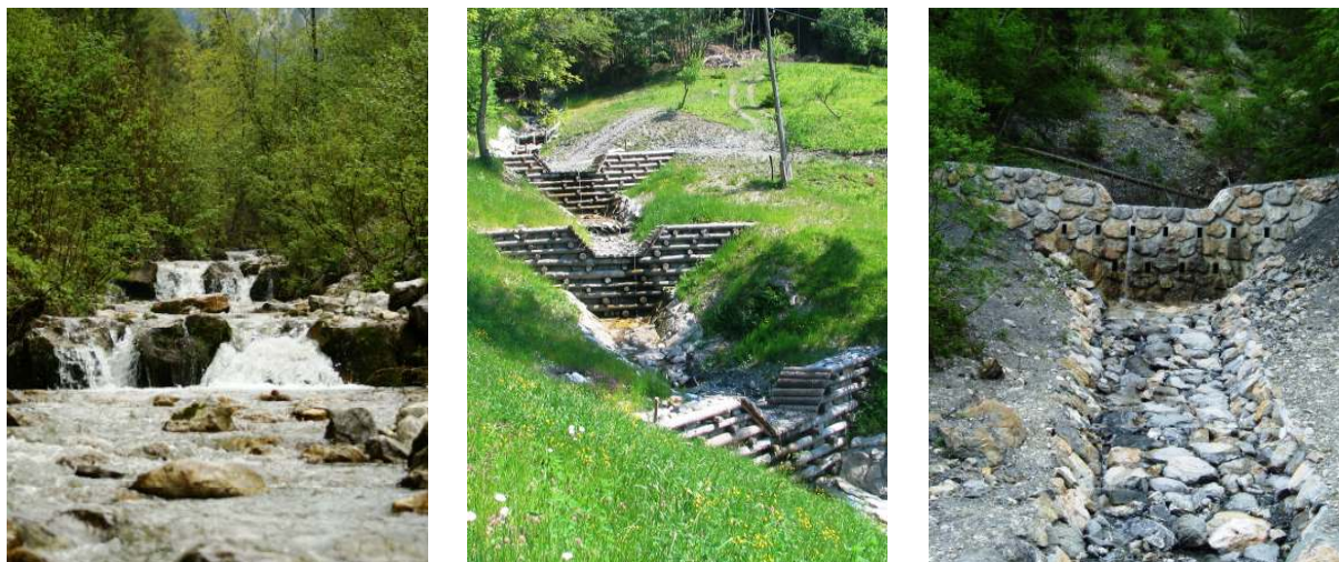
Slika 1, 2, 3. Ustrezno umeščeni, dimenzionirani in redno vzdrževani okolju prilagojeni tehnični objekti in biotehnične ureditve bodo tudi v prihodnosti pomemben del urejanja hudourniških območij v Sloveniji. (foto: J. Papež)
